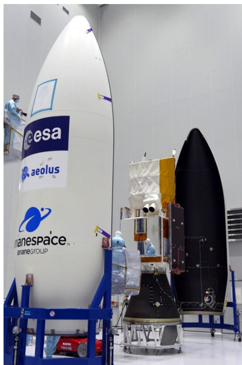
Figuur 6 Het inpakken van de aardobservatiesatelliet AEOLUS in de neus van de VEGA. Bron: ESA
